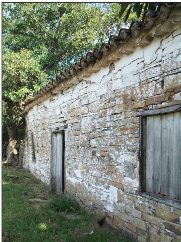
Figura 10: Residência desabitada próxima ao local da escavação. Fonte: Arquivo pessoal do autor.
